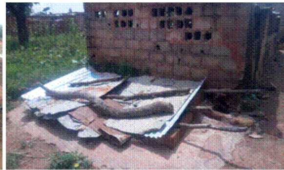
Photo 6: Fosse pour déjections d'un élevage porcin (cliché Tabouré, 2018)
